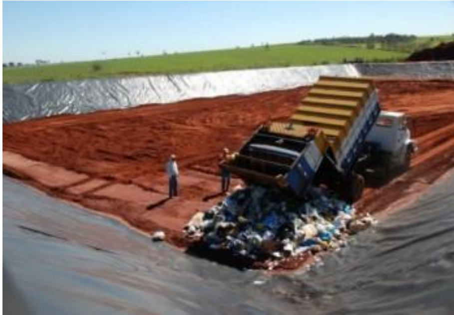
Figura 12 - Descarregamento de RSU em uma célula de aterro sanitário (Sempretops 2013).
