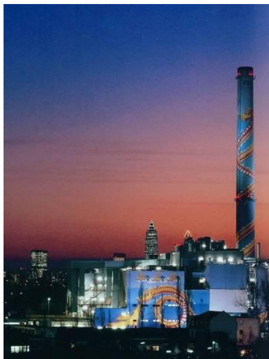
Figura 17 - Planta de incineração de RSU (Doosan 2012).
