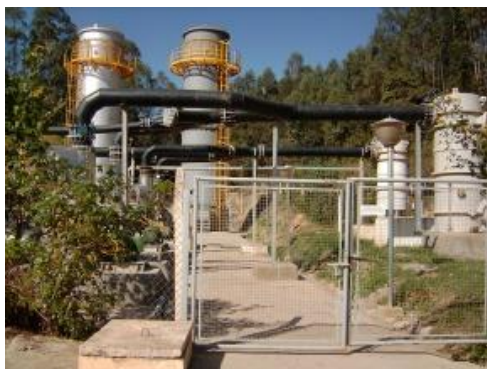
Figura 15 - Flares para queima de biogás (Globo.com 2013).
